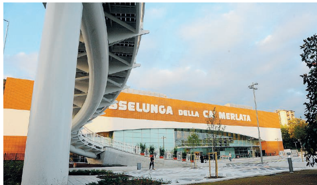
Il ponte su via Badone e la facciata del supermercato Esselunga, simboli della rinascita del quartiere di Camerlata a Como
