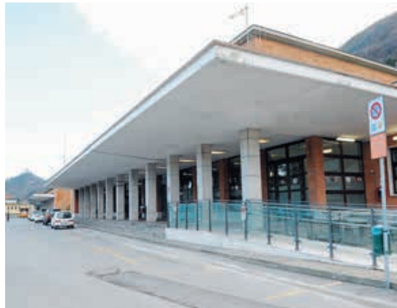
L’esterno della stazione San Giovanni. Da qui dovrebbe partire il tunnel verso il centro
