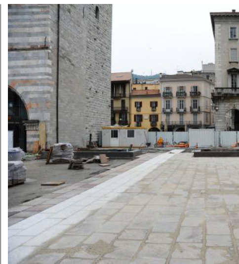
Così appare il cantiere di piazza Grimoldi dopo la copertura
